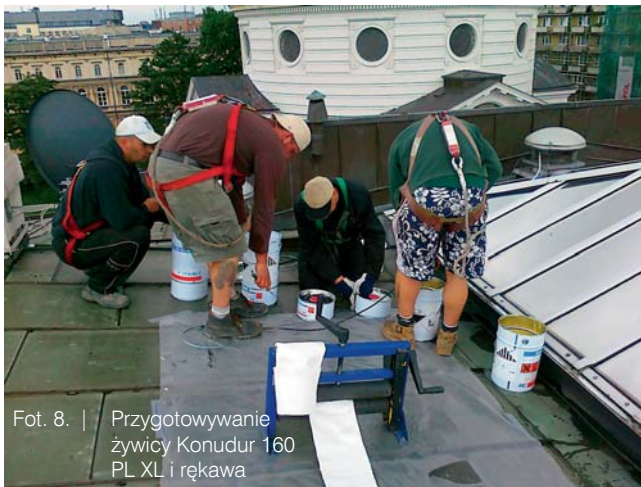
Fot. 7. | Prace na dachu Zachęty - nasączenie żywicą epoksydową Konudur 160 PL XL rękawa Brawoliner®
