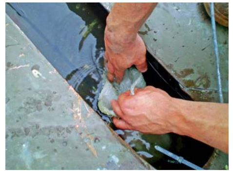
Fot. 10. | Otwarcie górnego końca rękawa oraz przeprowadzenie próby szczelności spustu
