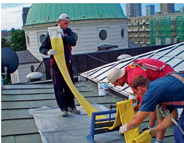
Fot. 9. | Rozprowadzanie żywicy w rękawie z pomocą rolek dociskowych oraz kontrola jakości nasączenia rękawa
