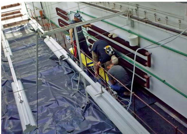
Fot. 2. | Prace na poddaszu Zachęty – nasączenie żywicą epoksydową Konudur 160 PL XL rękawa Brawoliner®
