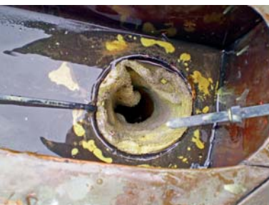
Fot. 14. | Próba szczelności spustu wody opadowej (wlot spustu – dach)
