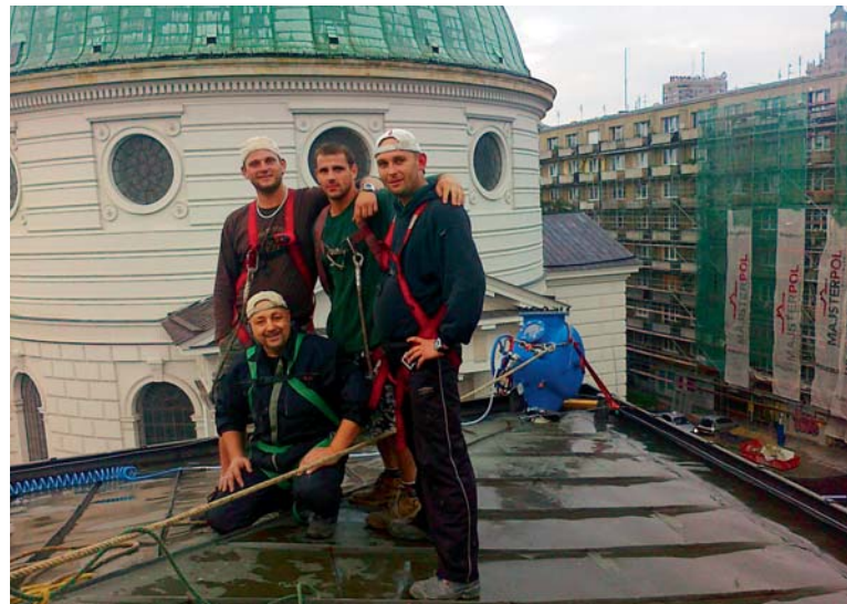
Fot. 13. | Pracownicy Z.U.H. Opolkan Serwis oraz Technicy zastosowań MC-Bauchemie
