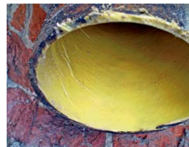
Fot. 17. | Obróbka rękawa u wylotu spustu (po renowacji)
