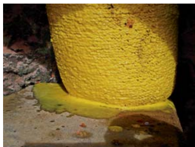
Fot. 15. | Zablokowanie rękawa u wylotu spustu (poziom gruntu) oraz proces utwardzania
