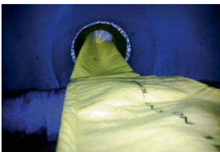
Fot. 6. | Przygotowanie rękawa Brawoliner ® oraz żywicy Konudur 160 PL XL
